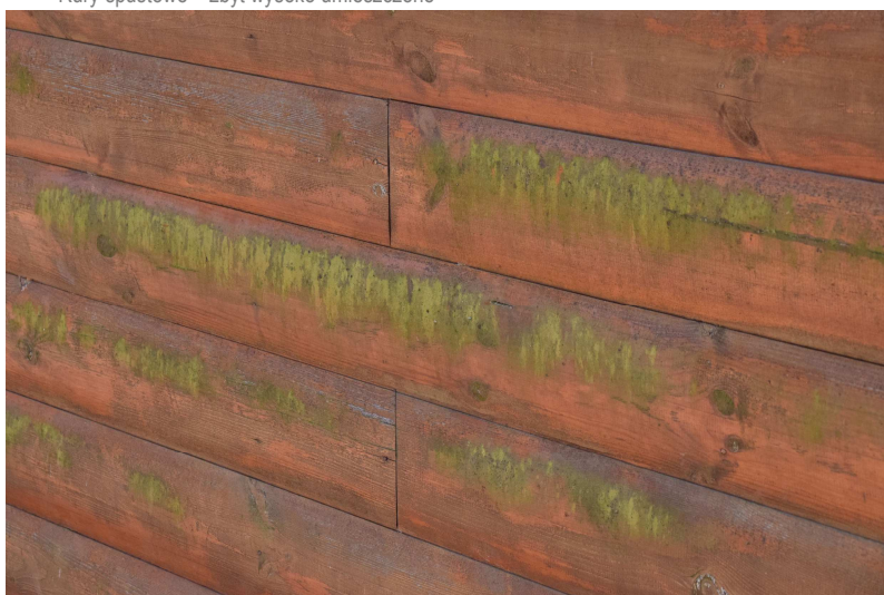
Szalówka elewacji zewnętrznej – widoczne zielone wykwity
