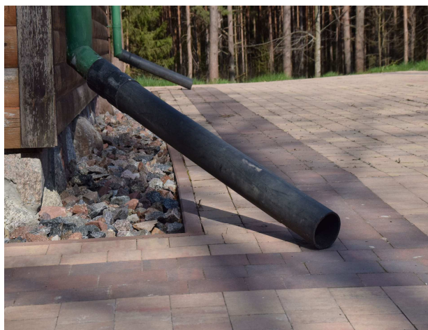
Rury spustowe – zbyt wysoko umieszczone
