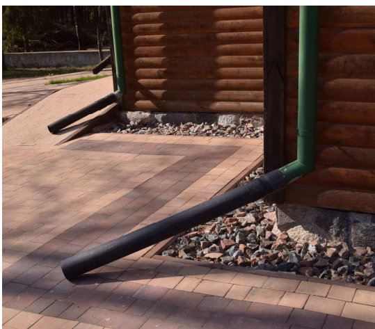
Rury spustowe – zbyt wysoko umieszczone
