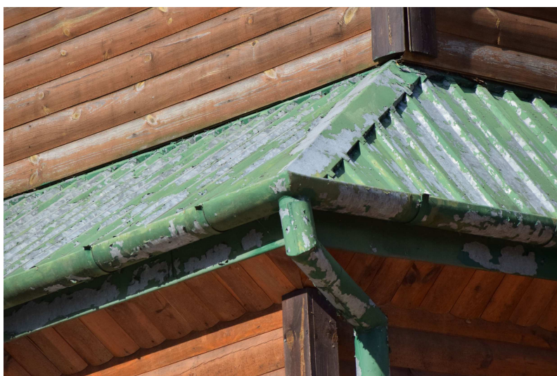
Widok stanu technicznego pokrycia dachowego.
