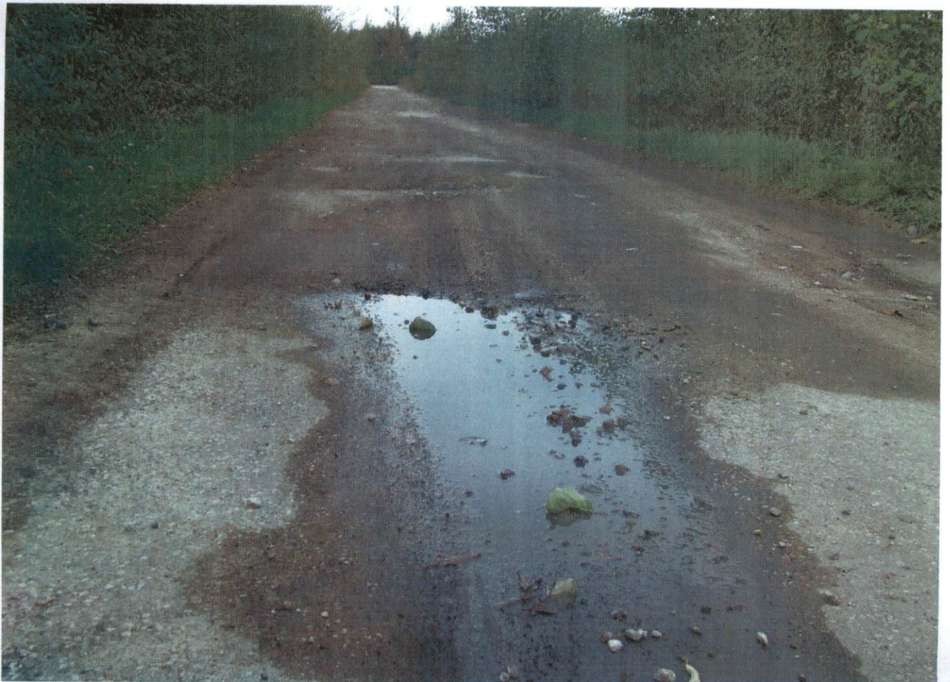
ZASYPANY ODCINEK DROGI OD STRONY DROGI POWIATOWEJ
